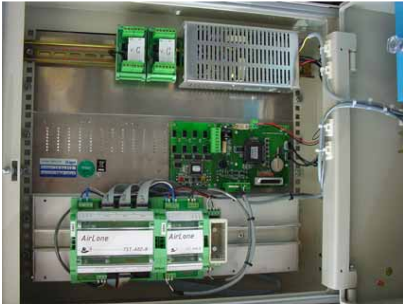
Intégration d'une TST-A02-R et d'une TST-A15-D dans un Comytron 30RS
