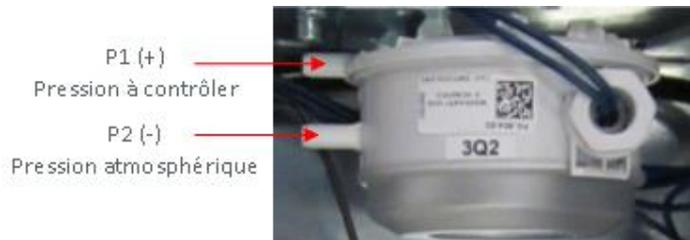
Raccorder les deux entrées du pressostat à l'aide du tube cristal fourni.
