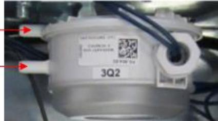
Raccorder les deux entrées du pressostat à l'aide du tube cristal fourni.
